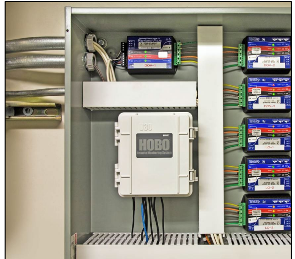
(d) Installed U30 logger
