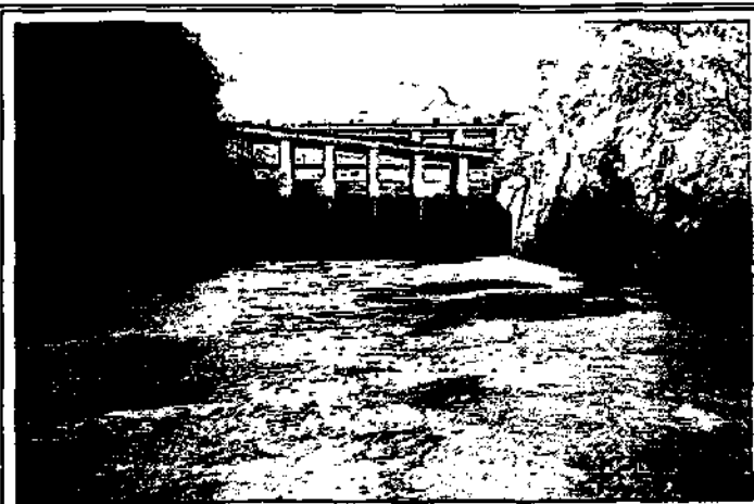
G.1. Nagledam. Afvoerkanaal.
