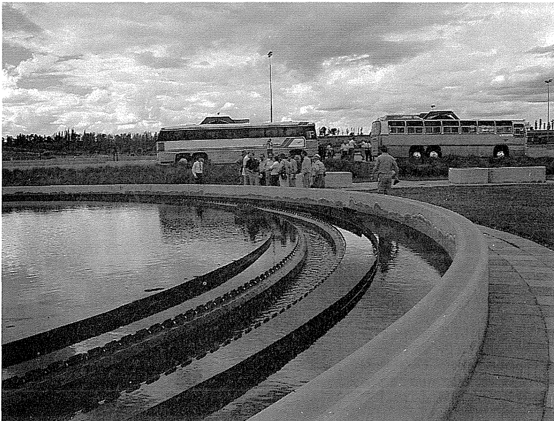
'n Sekondêre verhelderaar by die Noordelike Rioolwatersuiweringswerke, Johannesburg, waar navorsing oor biologiese fosfaatverwydering gedoen word.
