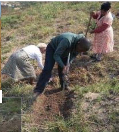
Ukwembiwa kwemisele ezofakelwa ematye kwenzelwa idama.
