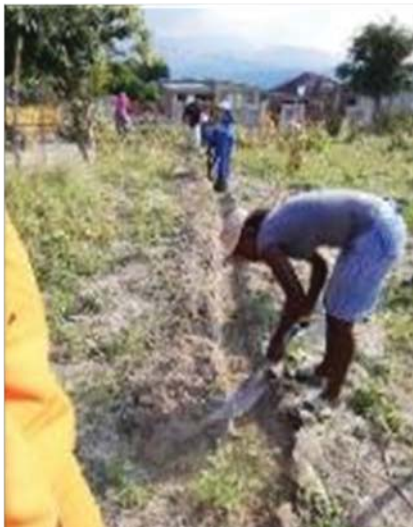
Ukumbiwa komsele ongajulile 30 cm ububanzi no 15 cm ukujula phezu kwekhontolo nsimini
