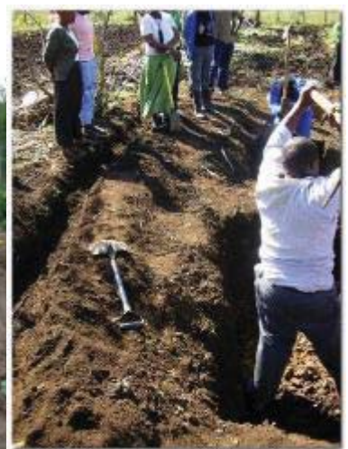
Ukumbiwa kwemibhede ejulile ngezansi kwe "swale"
