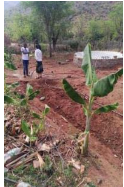
Tanka e feletšego ya ditena e e rulwetšego go sireletšega. Le foro ya go sepidisa meetse tankeng
