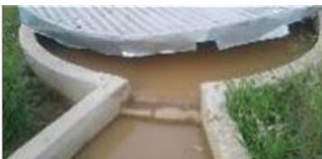
Mohlala wa tanka ya ka fase ga le fase (18m 3 ) ka setswalo se segonang go tloswa(Acornhoek)
