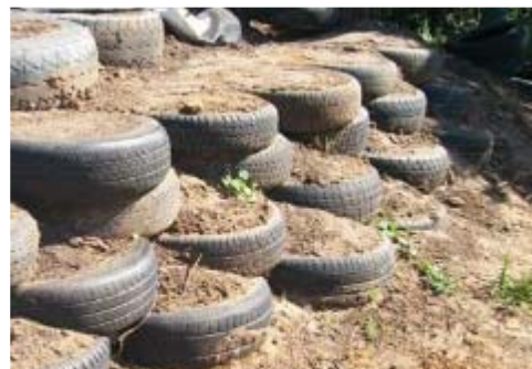
Merara e ka agwa ka ditaere tsa kgale nageng tse disenang matlapa
