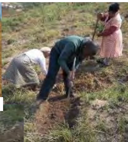
Ukwembiwa kwemisele ezofakelwa ematye kwenzelwa idama.
