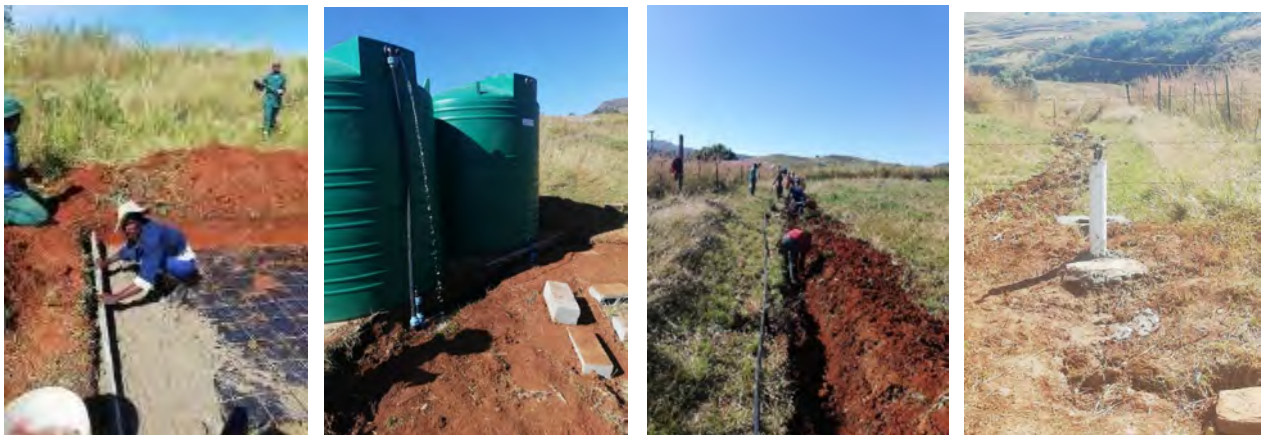
Ngaphezulu ngasekhohlo ukuya ekunene: Ukwakhiwa kweqonga lekhonkrithi letanki. Itanki ezimbini ze-Jo-Jo ezingama-2500L ezidityanisiweyo. Ukumba imisele nokubeka imibhobho impompo zabahlali. Umzekelo wetaphu yoluntu egqityiweyo.
