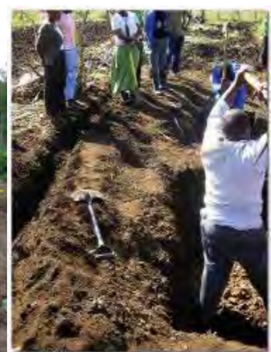
Ukumbiwa kwemibhede ejulile ngezansi kwe "swale"
