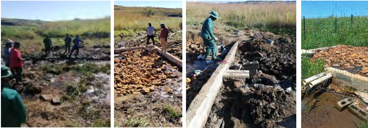
Ngenhla kusuka kwesokunxele kuya kwesokudla: umthombo ngaphambi kokuvikelwa e Stulwane e Bergville. Udonga lapho kuthathwa khona amanzi elino v-box ekhona elingezansi kwase kumbozwa ngamatshe nesihlabathi eduzane nehlo lomthombo. Ukwakhiwa kwamapayipi azokhipha amanzi ngaphandle uma sekugcwele, umthombo osuvikelwe wabiywa nangofenisi.
