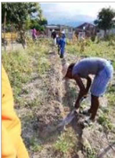
Ukumbiwa komsele ongajulile 30 cm ububanzi no 15 cm ukujula phezu kwekhontolo nsimini
