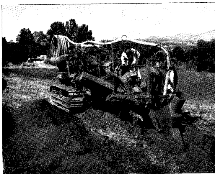
Figuur 3 Onderdreins is geïnstalleer met die hand, en deur middel van 'n aantal meganiese skopgrawe, 'n omgeboude wielslootgrawer en twee graafketting "dreineermasjiene"
