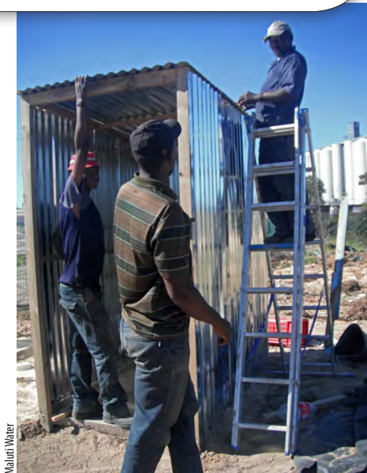
Construction of the demonstration pour flush toilet in Klipheuwel.
